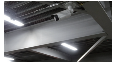
低照度環境でも映像の確認が可能な赤外線照射機能付きカメラ
