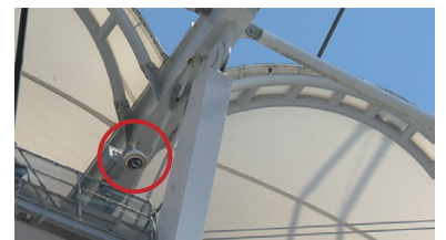
スタジアム内外に設置され、広範囲を撮影する旋回ズーム型カメラ
