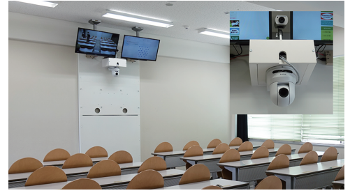
教室後方に設置された教員撮影用の旋回型カメラと板書を俯瞰で捉える固定型カメラ
