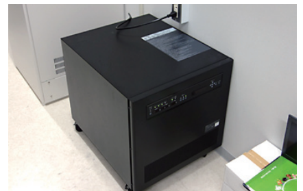
節電やバックアップ電源の確保、クリーンエネルギー採用などの理由から蓄電池「ESSP-3000」も採用された。
