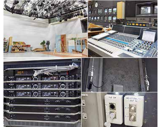
料理番組などの収録で運用されている第6・7スタジオ/スタジオサブ。DWT-B01N/G、DWM-02N/Gなどにより、1.2GHz帯18波での運用が可能になっています。また、リモートLAN端子、アンテナ端子などを装備し、持ち出し用1.2GHz帯の運用にも柔軟に対応。
