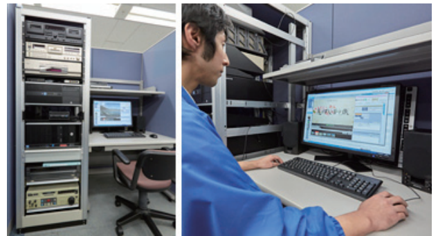
ファイル化し、プレビューを終えたコンテンツをアーカイブシステムサーバーに登録。そこからコントロールサーバーを介してオプティカルディスク・アーカイブに正・副で最終アーカイブされます。
