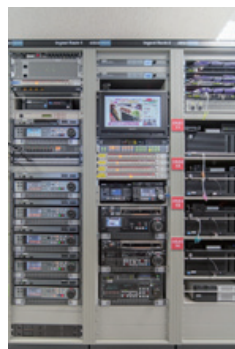
報道フロア内の回線収録・インジェストブース。XDCAM Station XDS-1000を5式使用し、さまざまなフォーマットの報道取材映像のインジェストならびに回線収録を行います(左)。同時に、メタデータの付加作業を端末で行います(右)。
