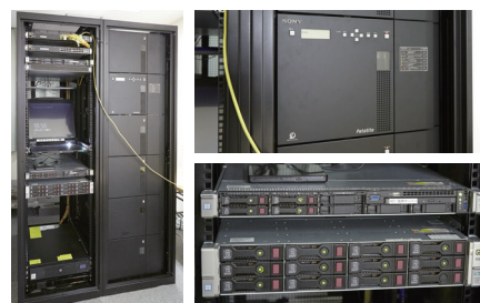
PetaSite 拡張型ライブラリーにも対応。マスターユニット ODS-L30M を1式、ドライブ拡張ユニット ODS-L60E を1式、カートリッジ拡張ユニット ODS-L100E を4式、第2世代のドライブユニット ODS-D280F を3式装備することでより大容量のアーカイブ保存を可能にしています。
