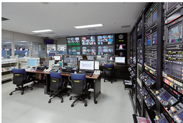
報道NVシステム「F-BINUS」が稼働している報道NV室。写真・左が収録エリア。ファイルサーバーへの収録と同時にXDCAMデッキでバックアップ収録を兼ねた一次アーカイブ用PFDの生成を行う。
