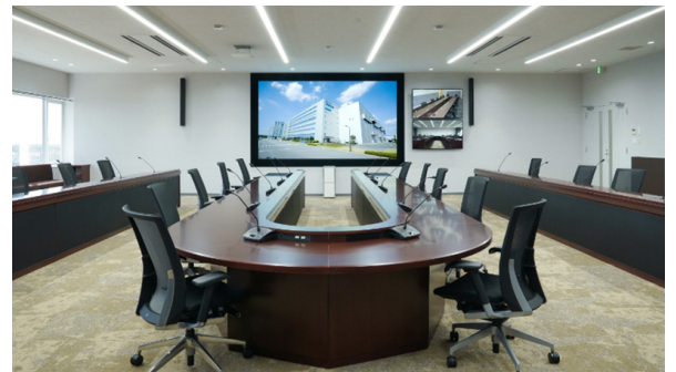
前方のプロジェクターとモニターを挟んで左右に設置されている ラインアレイスピーカー
