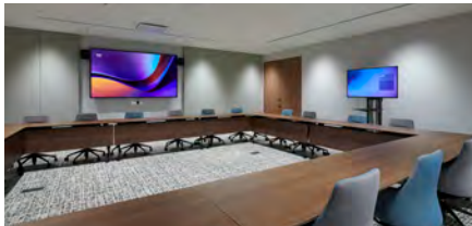
100V型を設置した大会議室。ここでもサブモニターを設置している。
